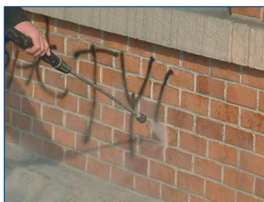
przykład usuwania graffiti z cegły, zabezpieczonej środkiem AGS 3512
