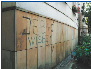
przykład usuwania graffiti z piaskowca, zabezpieczonego środkiem AGS 3500
