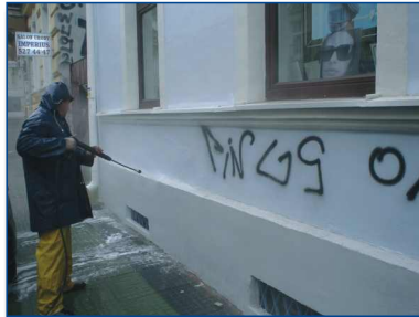
przykład usuwania graffiti z tynku cementowo-wapiennego, zabezpieczonego środkiem AGS 3502
