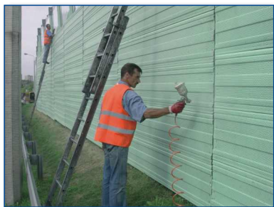
nakładanie zabezpieczenia
