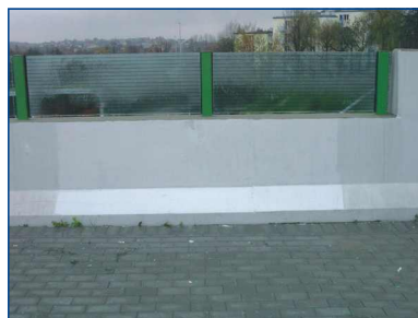
przykład usuwania graffiti z betonu, zabezpieczonego środkiem AGS 3506
