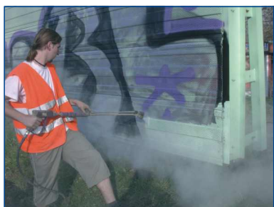
usuwanie graffiti gorącą wodą pod ciśnieniem
