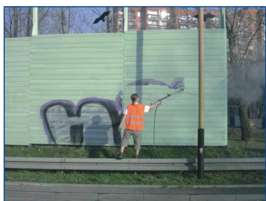
usuwanie graffiti gorącą wodą pod ciśnieniem
