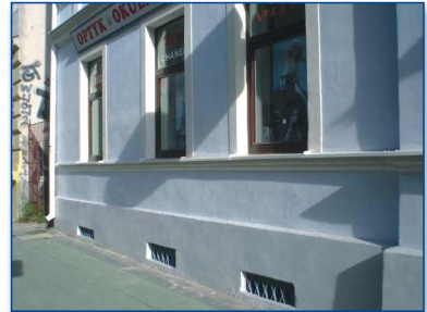
przykład usuwania graffiti z tynku cementowo-wapiennego, zabezpieczonego środkiem AGS 3502
