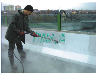
przykład usuwania graffiti z betonu, zabezpieczonego środkiem AGS 3506
