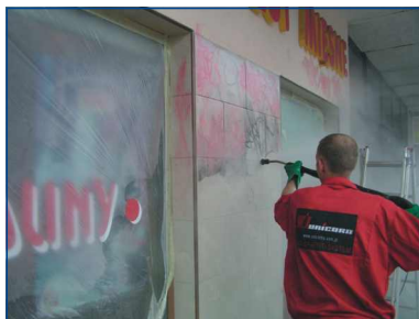
przykład usuwania graffiti z glazury, zabezpieczonej środkiem AGS 3510
