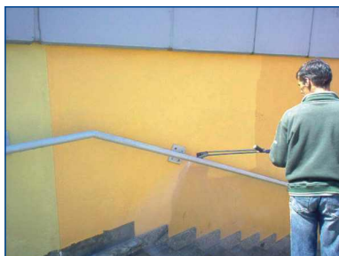
przykład usuwania zabezpieczenia AGS z malowanego betonu, za pomocą środka AGS 3505 i gorącej wody pod ciśnieniem
