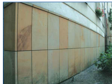
przykład usuwania graffiti z piaskowca, zabezpieczonego środkiem AGS 3500
