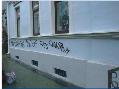
przykład usuwania graffiti z tynku cementowo-wapiennego, zabezpieczonego środkiem AGS 3502
