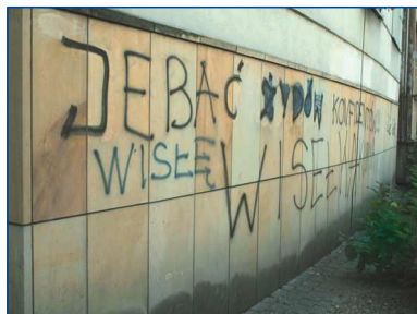
przykład usuwania graffiti z piaskowca, zabezpieczonego środkiem AGS 3500
